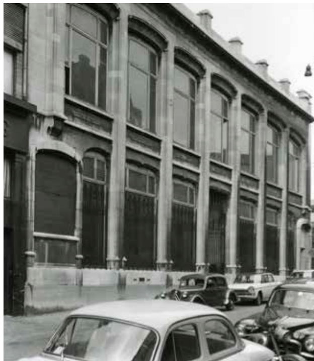
Façade des Magasins Waucquez, années 60
